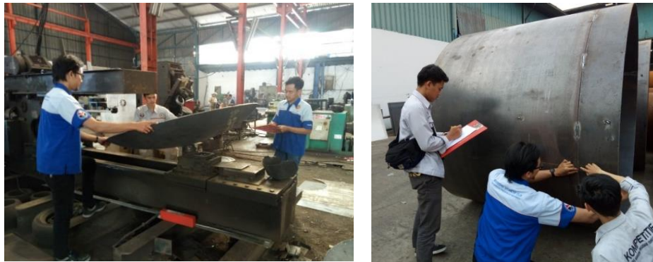
Gambar 9. Proses Pembuatan Incinerator
