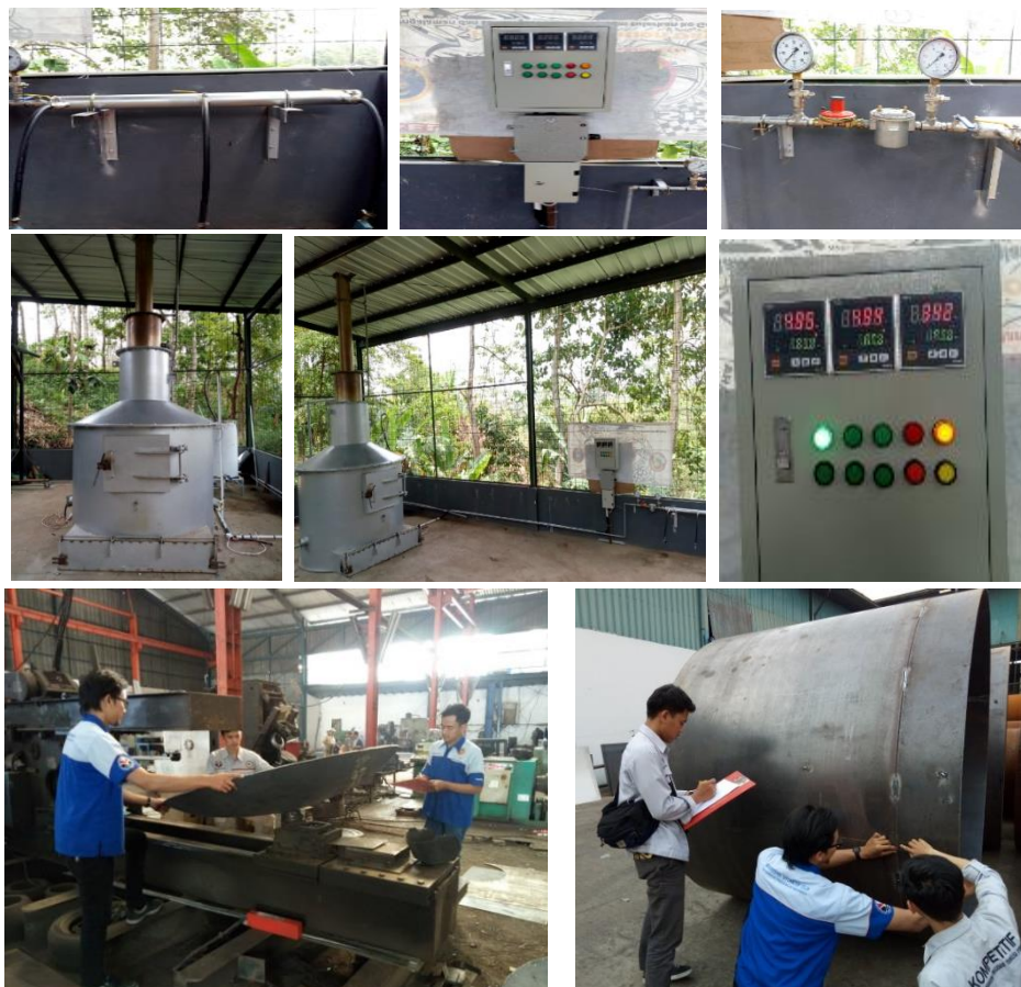
Gambar 22 Proses Pembuatan Incinerator
