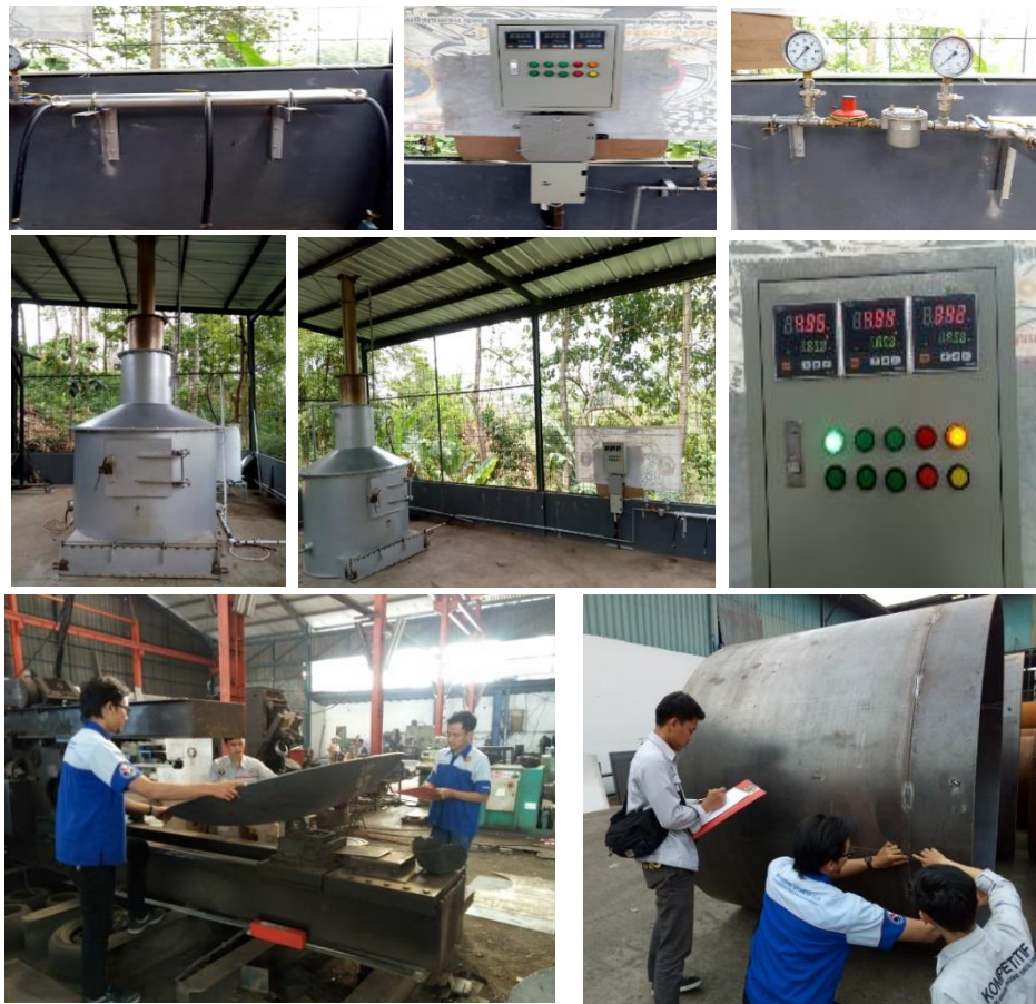
Gambar 25 Proses Pembuatan Incinerator
