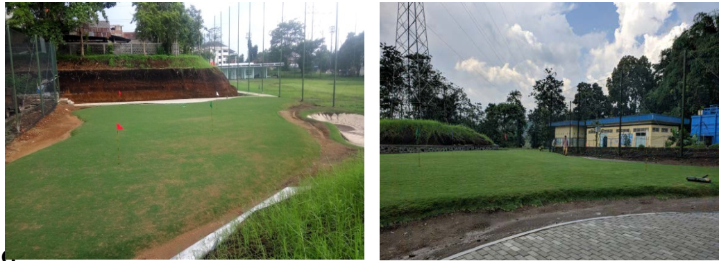
ambar 25. Pembangunan Driving Range
