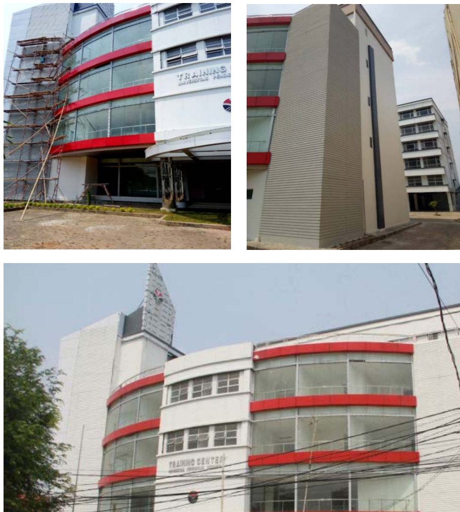
Gambar 24. Penyelesaian Pembangunan TC Serang
