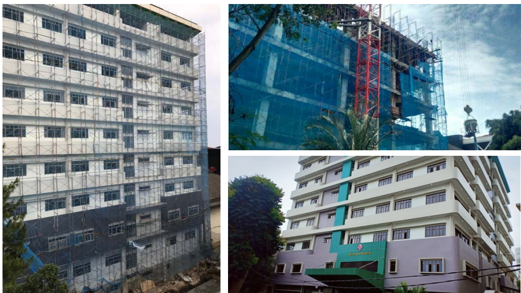
Gambar 23. Pembangunan Gedung FIP
