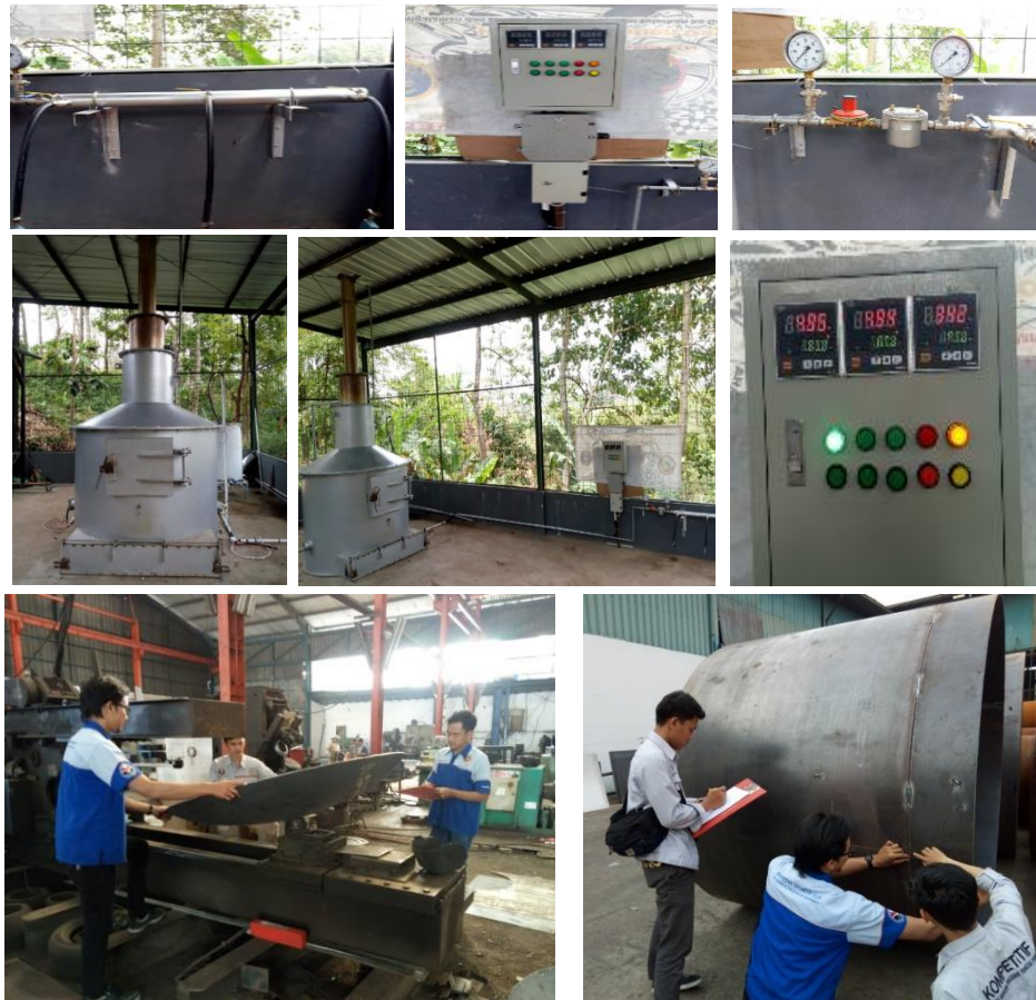
Gambar 3.16. Proses Pembuatan Incinerator
