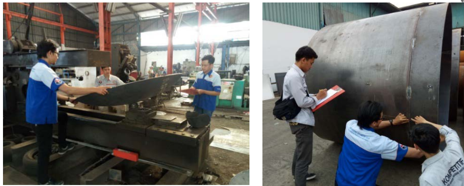
Gambar 3.25. Proses Pembuatan Incinerator
