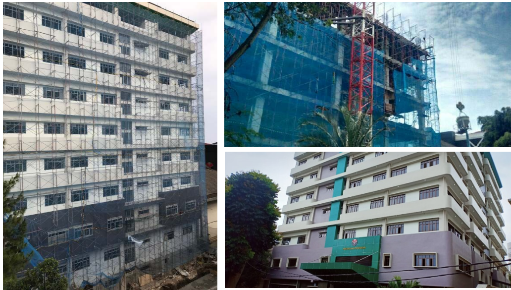
Gambar 3.23. Pembangunan Gedung Fakultas Ilmu Pendidikan (FIP)
