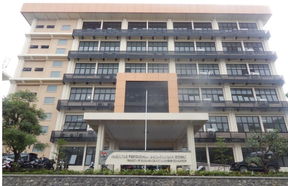
Gambar 4.3-2 Gedung FPEB – Hasil Pembangunan tahun 2015
